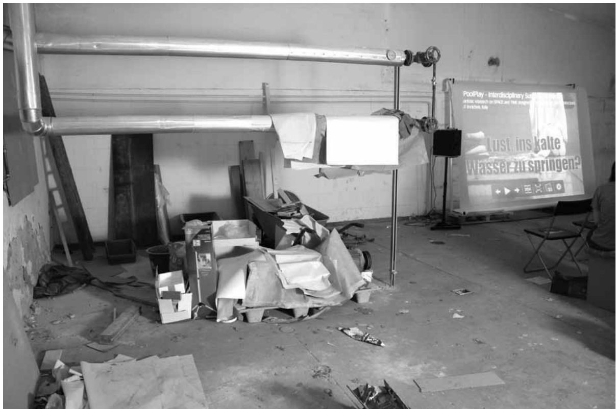
Das Kesselhaus im Umbau. Es wird als Performance- und Projektraum von Medien- und Druckwerkstatt genutzt.
