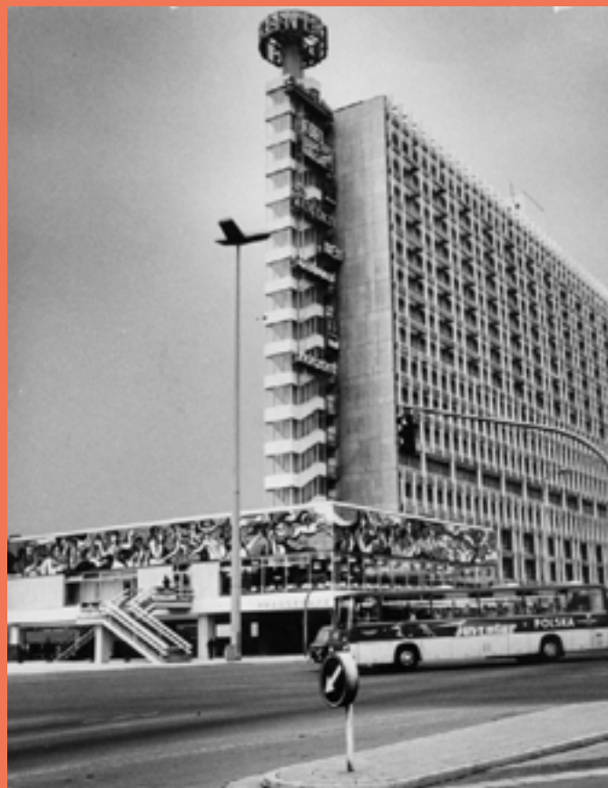
©Berliner Verlag, Verlagsgebäude, Foto: Helfried Strauß
